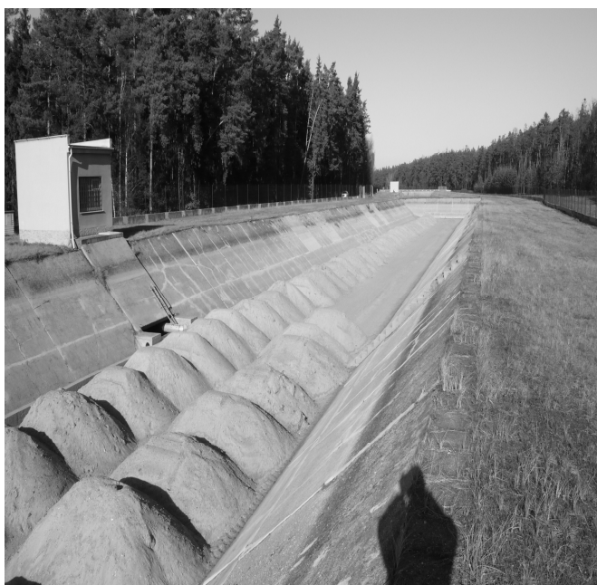
Vsakovací nádrž při navážení a po urovnání
